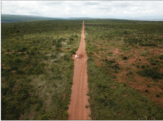
Foto 2.3.2-11 - Acessos não pavimentados na área de estudo
