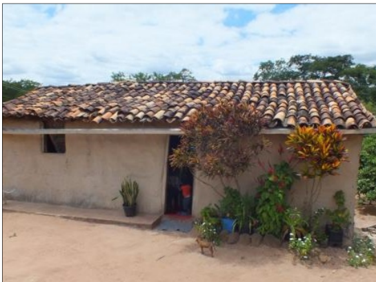
Foto 3.5.2-20 - Ponto 7 - Área de habitação de Anália Pereira. Coordenadas Geográficas UTM 23K: 756534 / 8210153.
