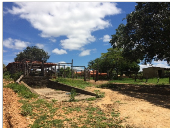
Foto 2.3.2-14 - Instalação rural presente na área de estudo
